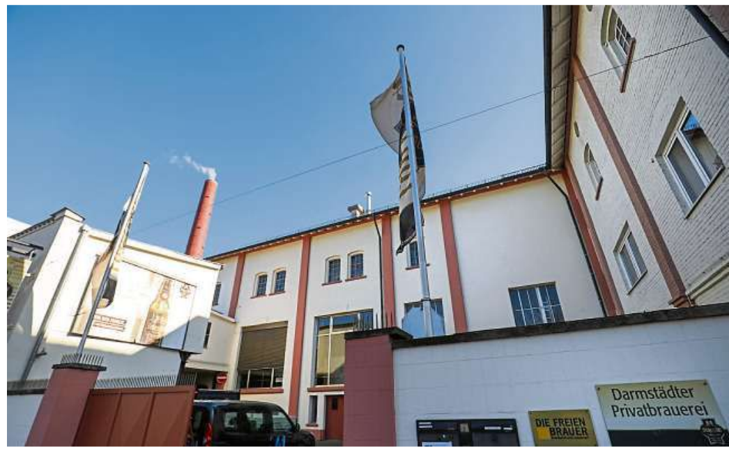
Blick auf das Gelände der Darmstädter Brauerei. Die Erneuerung des Flaschenkellers ist das größte Einzelprojekt der Firmengeschichte und mit einem Investitionsvolumen von knapp 5 Millionen Euro auch das teuerste.
